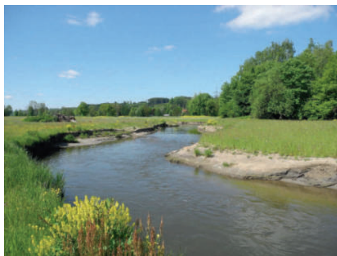
Zustand ein Jahr nach Ausbau (Mai 2021) Steilufer, Kiesbänke, Kolke und Flachwasserzonen
