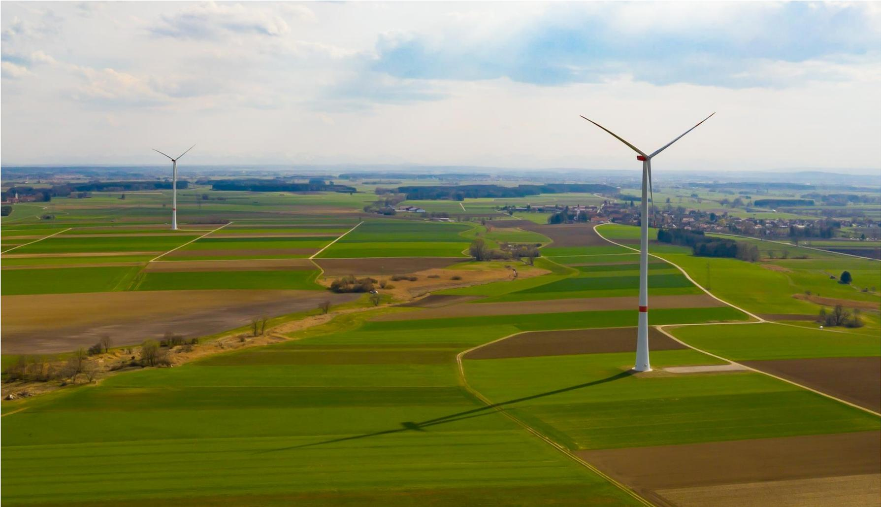
Zwei N 117 in Lamerdingen im LK OAL, NH 140 m, Leistung je 2,4 MW, Inbetriebnahme Ende 2014, Produktion je 6 Mio. kWh/a
