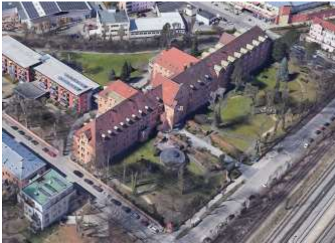
Servatiusstift 2015 Quelle: Google Earth
