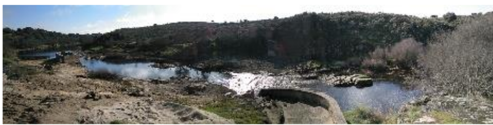
Damm Yecla de Yeltes, Spanien, nach dem Abbruch, Januar 2019; Foto: www.damremoval.eu
