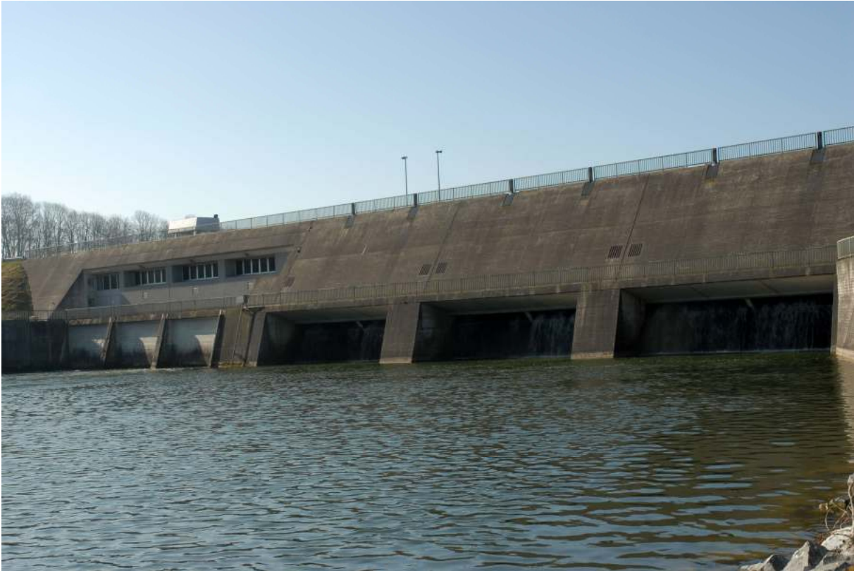
Abb. 5: Wasserkraftwerk am Lech Stau 19 (Foto: E. Pfeuffer)
