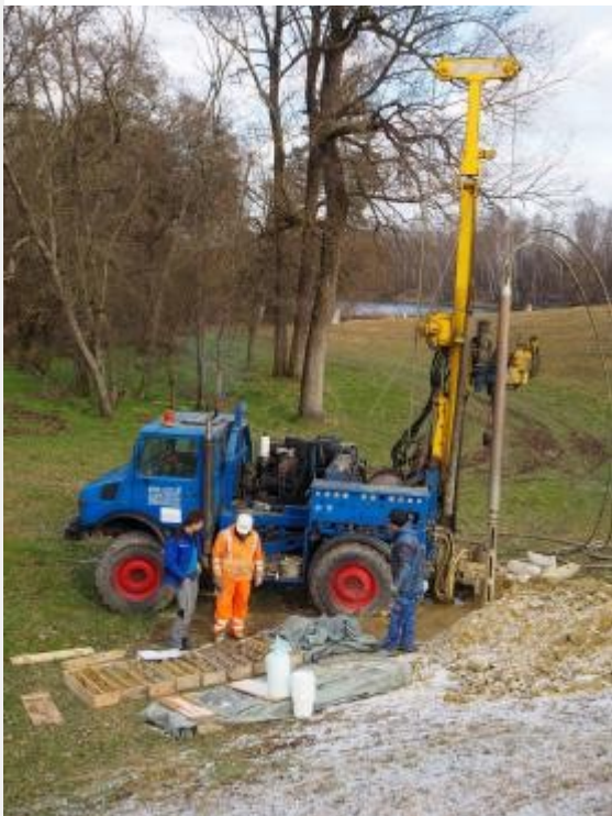
Abb. 2: Durchführung von Rammkernsondierungen bei FI-km 53,4
