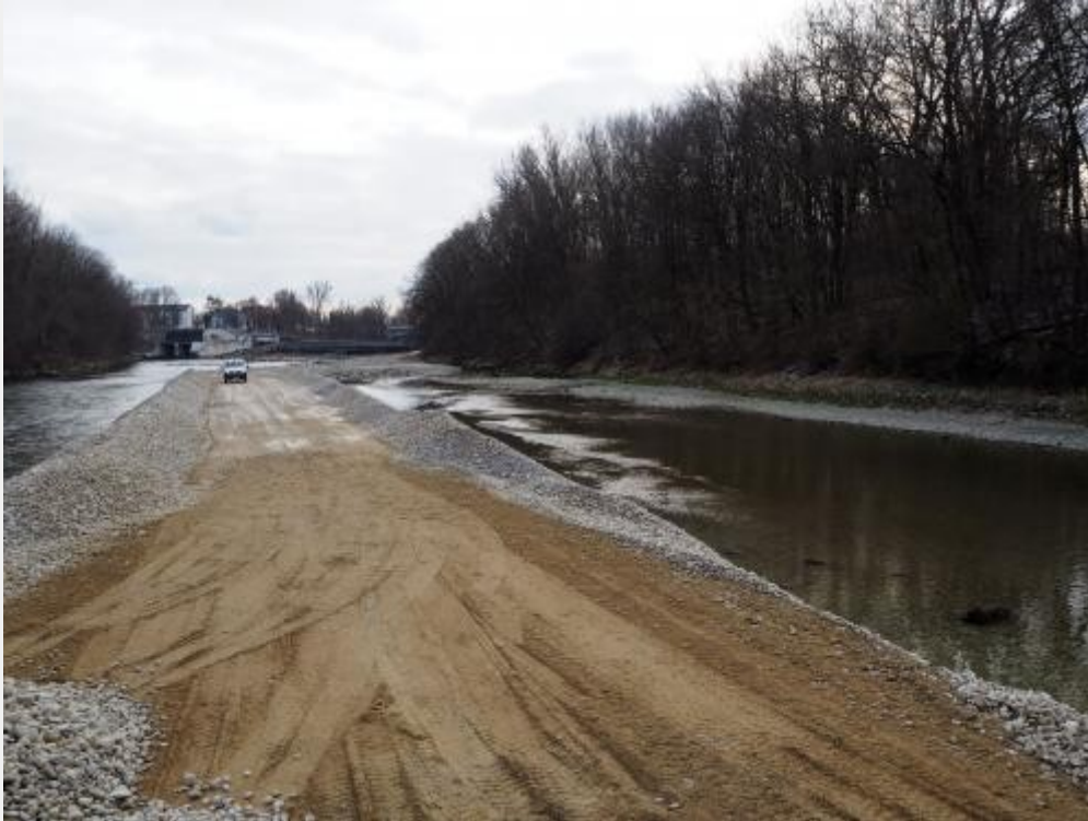
Abb. 7: Zugabe von Kies unterhalb des Eisenbahnerwehrs, Aufnahme von Ende Januar 2023
