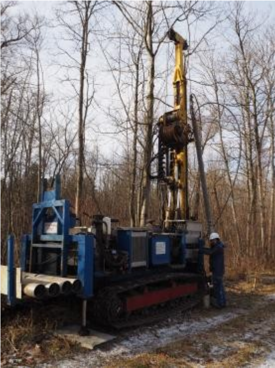
Abb.3: Durchführung von Bodenerkundungen entlang der Uferwege
