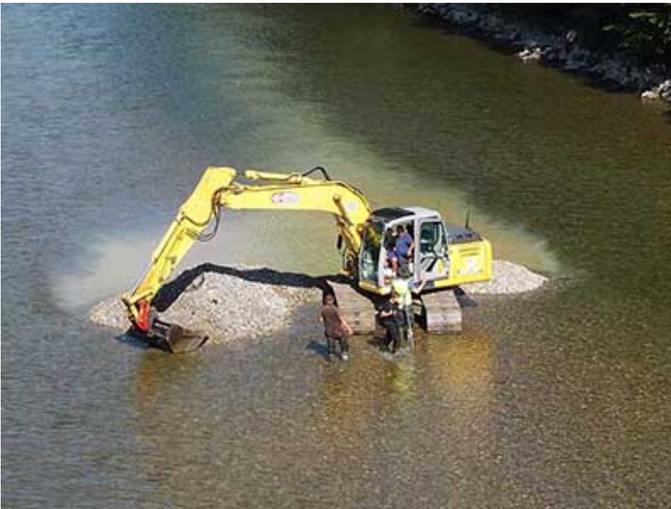
Baggerschürfe im Flussbett flussabwärts der Ulrichsbrücke
