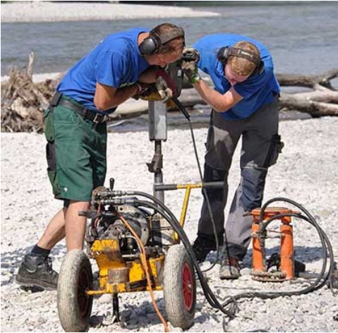
Entnahme von Rammkernsondierungen mithilfe von Sondierhämmern
